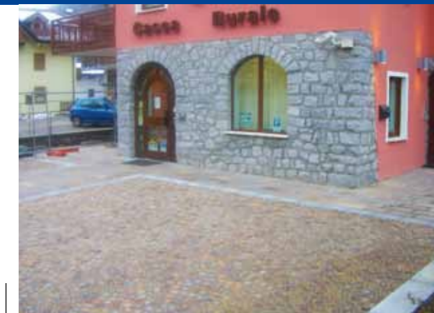
Il piazzale rinnovato alla filiale di Cogolo.
